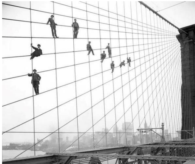
Figura 23 I cavi di sospensione del ponte di Brooklyn a New York (dal New York City Municipal Archives – www.zingrate.com )
