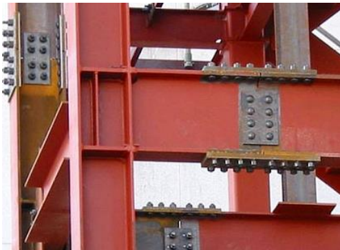
a. Giunzione di continuità trave-trave e colonna-colonna
