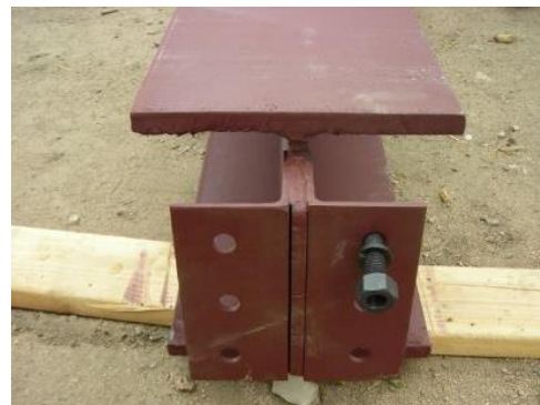
d. Collegamento trave-trave con angolari
