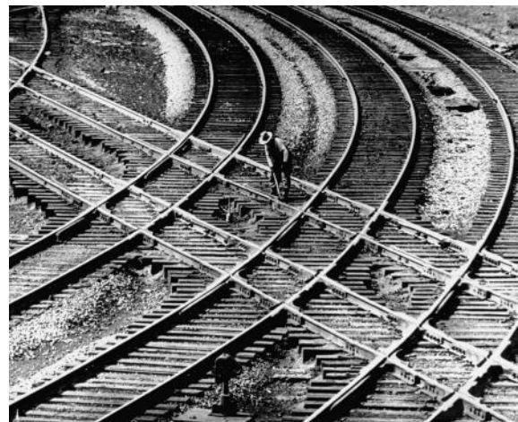
Figura 14 Esempio di tipico incrocio ferroviario a livello
